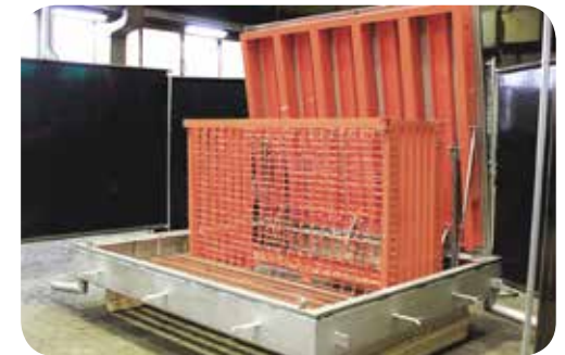
Rekkverk ferdig montert
